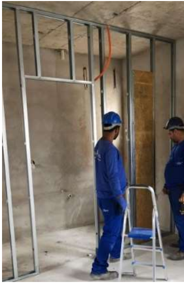
Instalação das guias de piso, parede e teto
