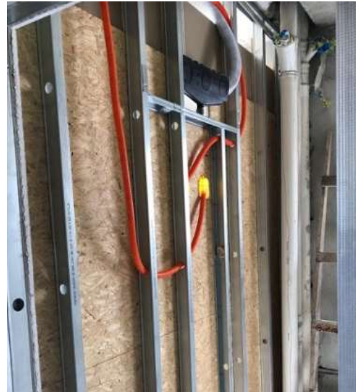
Chapas de gesso instaladas em um dos lados da parede
