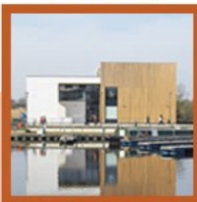
FACHADA LATERAL ESQUERDA
