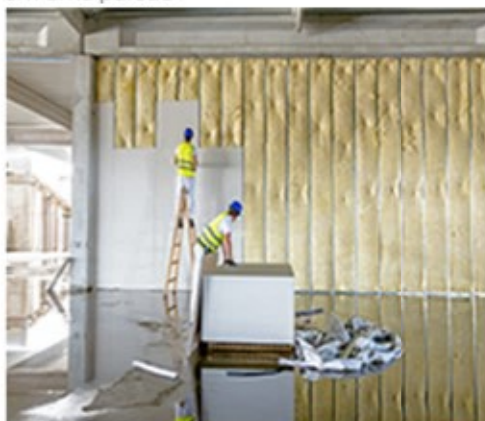
·Img. 09: Profissionais aplicando lã de vidro em uma parede
