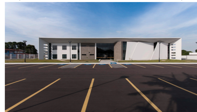
Imagem 26: Fachada frontal do Centro Cultural Cajuru
