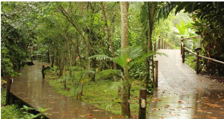
Figura 47: Passarela - estrutura suspensa em madeira
