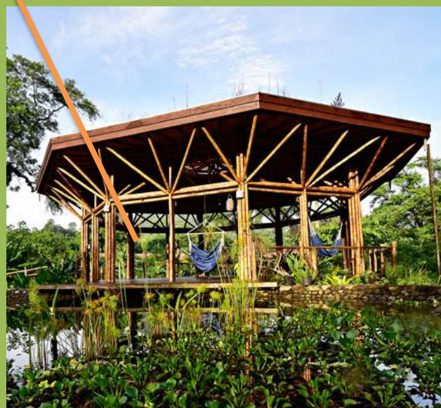
Figura 42: ESTRUTURA OCTAGONAL COM ENTRADA DE ILUMINAÇÃO NATURAL
