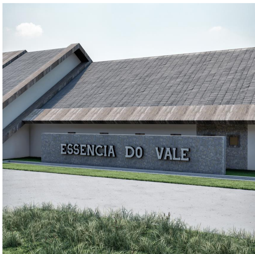
Figura 71: Paredes de pedra – Nome da Pousada
