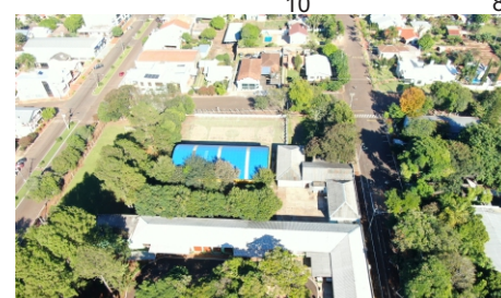
Figura 76: Equipamentos e serviços Fonte: Autor, 2020
