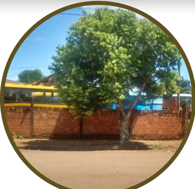
Figura 71: Lote adotado (01) Fonte: Autor, 2020
