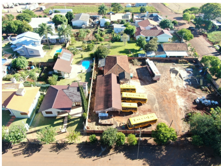
Figura 78: Lote adotado Fonte: Autor, 2020
