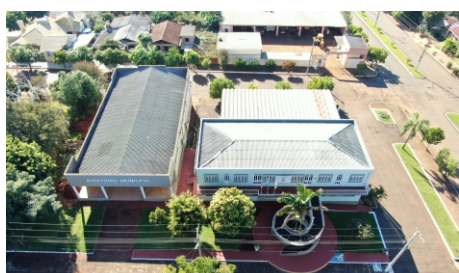
Figura 74: Equipamentos e serviços Fonte: Autor, 2020
