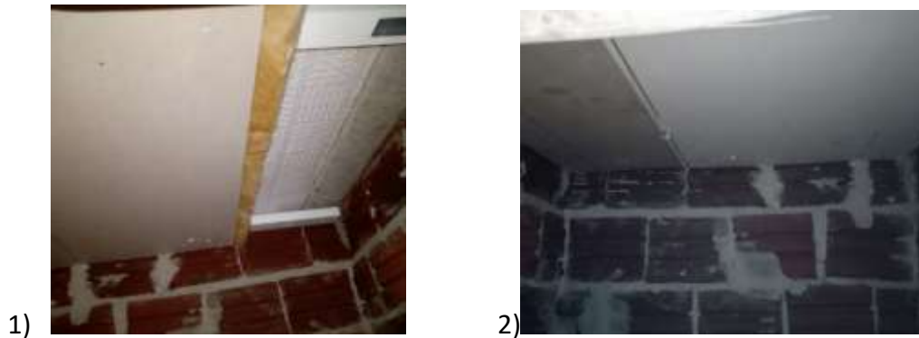
Figura 02: 1) Colocação do forro com lã de vidro e gesso acartonado em andamento. 2) Procedimento finalizado.
