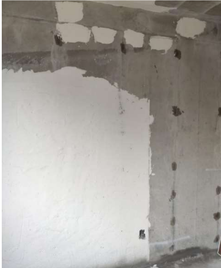
Figura 09- Nivelamento de paredes de concreto armado
