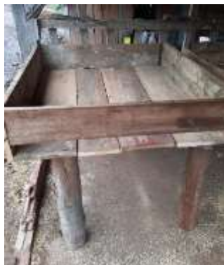
Figura 2: Estrutura pronta para o recebimento das camadas.
