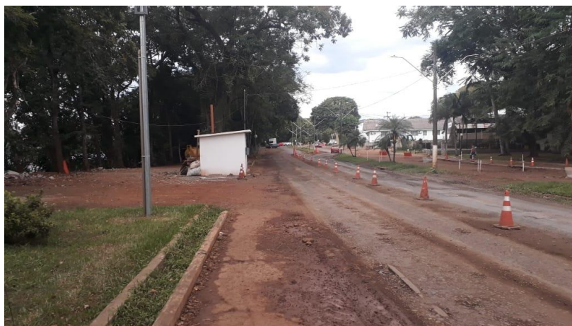
Figura 18 - Avenida Uruguai em reforma.
