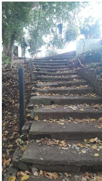
Figura 11 - Escadaria de acesso entre a Avenida Uruguai e o Rio
