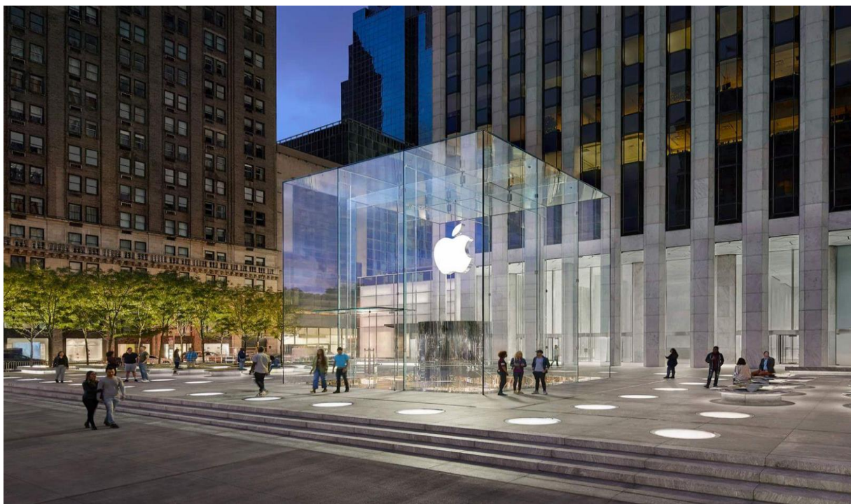
Figura 7 – Apple Store , Nova York — Fachada cúbica de vidro com estrutura mínima e máxima transparência, dissolvendo a fronteira entre urbano e interior.
